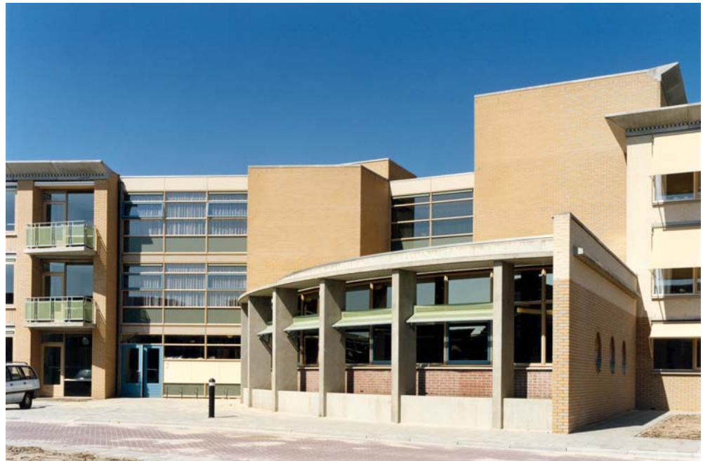
Rechts & onder: De nieuwe grootkeuken van Voor Anker: exterieur en interieur
